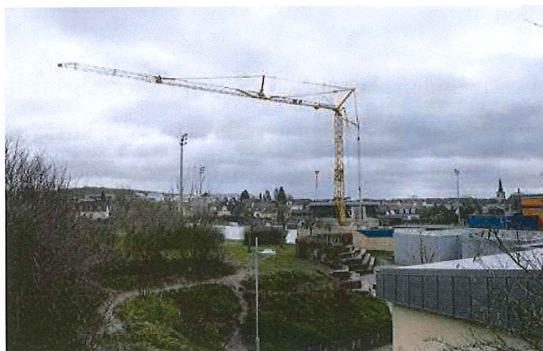
Dort, wo bis vor Kurzem der Schulpavillon stand, entsteht derzeit der neue Gebäudeteil. Foto: Guy Jallay
